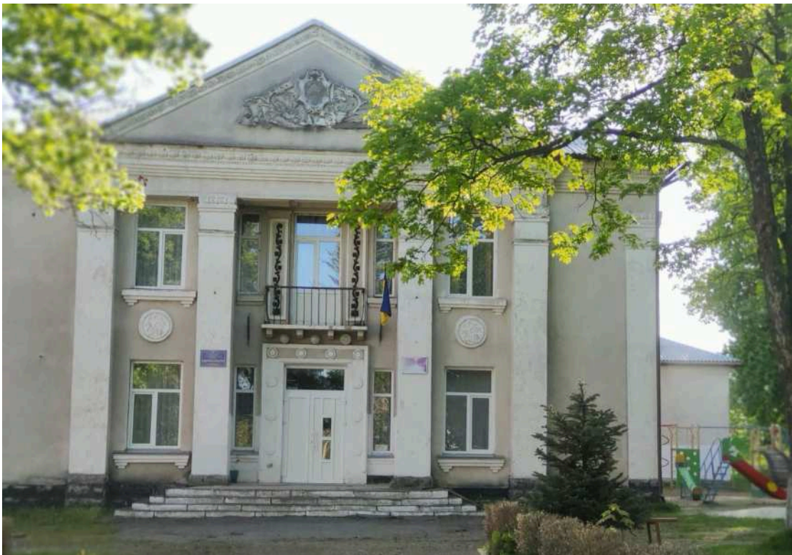
Відремонтовано дах будинку культури с.Ковалівка
