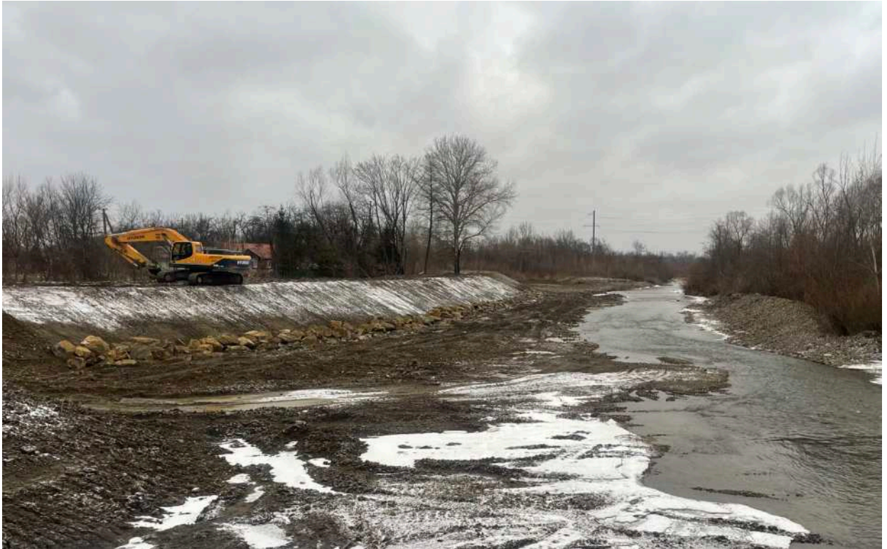
Нове будівництво дамби на р.Пістинька у с.Нижний Вербіж
